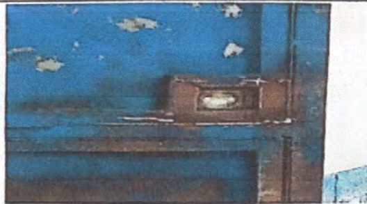
Foto 1: Cambio de Chapa
