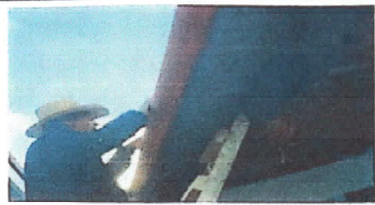
Foto 2: Bajada de agua Pluvial
