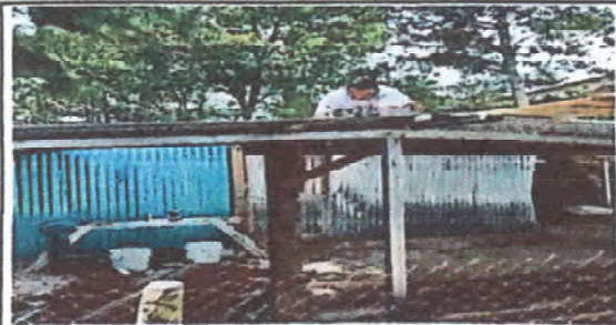
Foto 6: Sustitución de lámina troquelada aluzing
